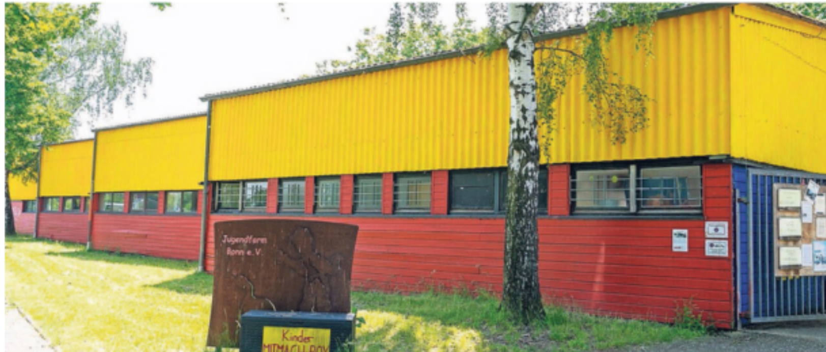
Dieser Gebäudekomplex der Jugendfarm am Holzlarer Weg wird abgerissen und durch einen Neubau ersetzt.
